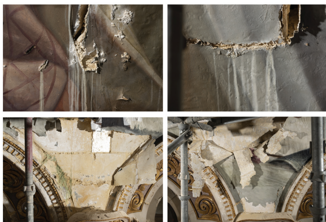
Ħsarat tal-pitturi marouflage li jiddekoraw il-koppla. Ritratti ta' Manuel Ciantar u Suzanne Ciantar Ferrito.
