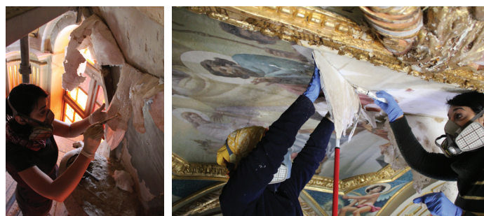
Detalji li ttiehdu waqt il-konservazzjoni li saret fl-ewwel fażi ta' dan il-proġett u li juru l-proċess ta' twaħħil ta' partijiet tal-pittura li kienu nqalgħu maż-żmien minħabba ingress ta' ilma. Ritratt ta' Amy Sciberras.
